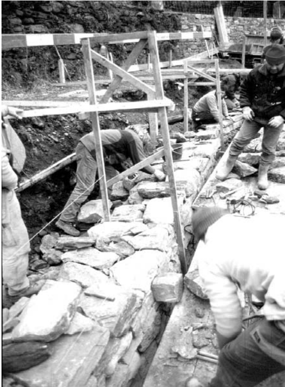
Abbildung 13: Stiftung Umwelt-Einsatz Schweiz, Bau einer Lasten tragenden Stützmauer in Verdabbio GR / Dezember 2002
