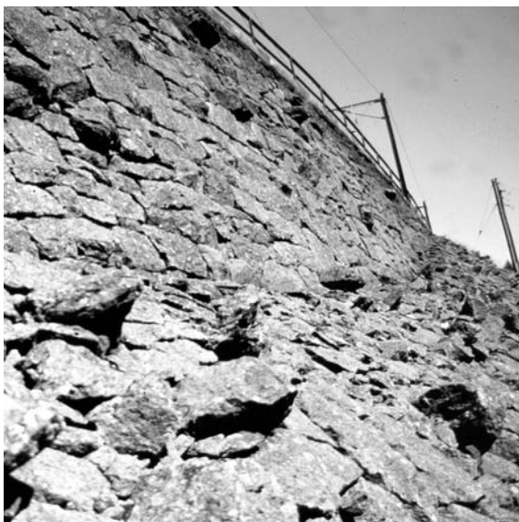
Abbildung 2: Gotthard-Bahn, Steinsatz mit aufgesetzter Stützmauer. Detailansicht.
