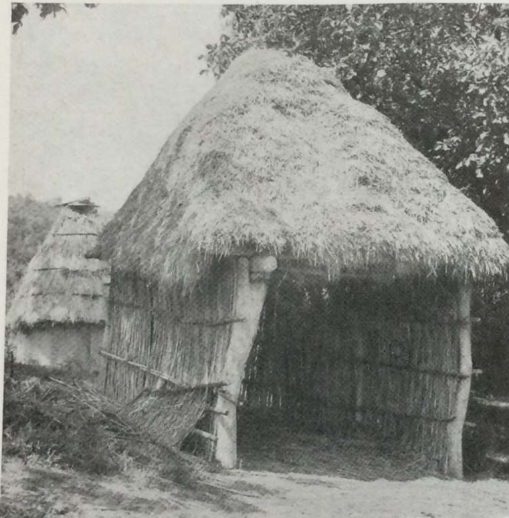
Der kleine Stallbau aus der Nähe von Florenz besteht aus einem Pfostengestell mit ebener Stangendeckung und pyramidenförmiger Wirstrohdiebedeckung.
